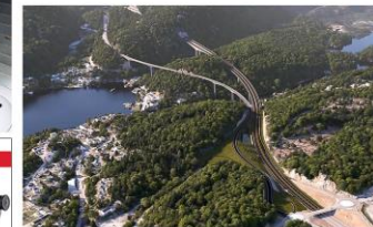
STÅL PROBLEMER: Stålleveransene til den nye tross over Langengen på E18 er blitt noe forsinket på grunn av krigen i Ukraina, men prosjektet er iverksatt i nå. ILLUSTRASJON: STATENS VEIETSEN
