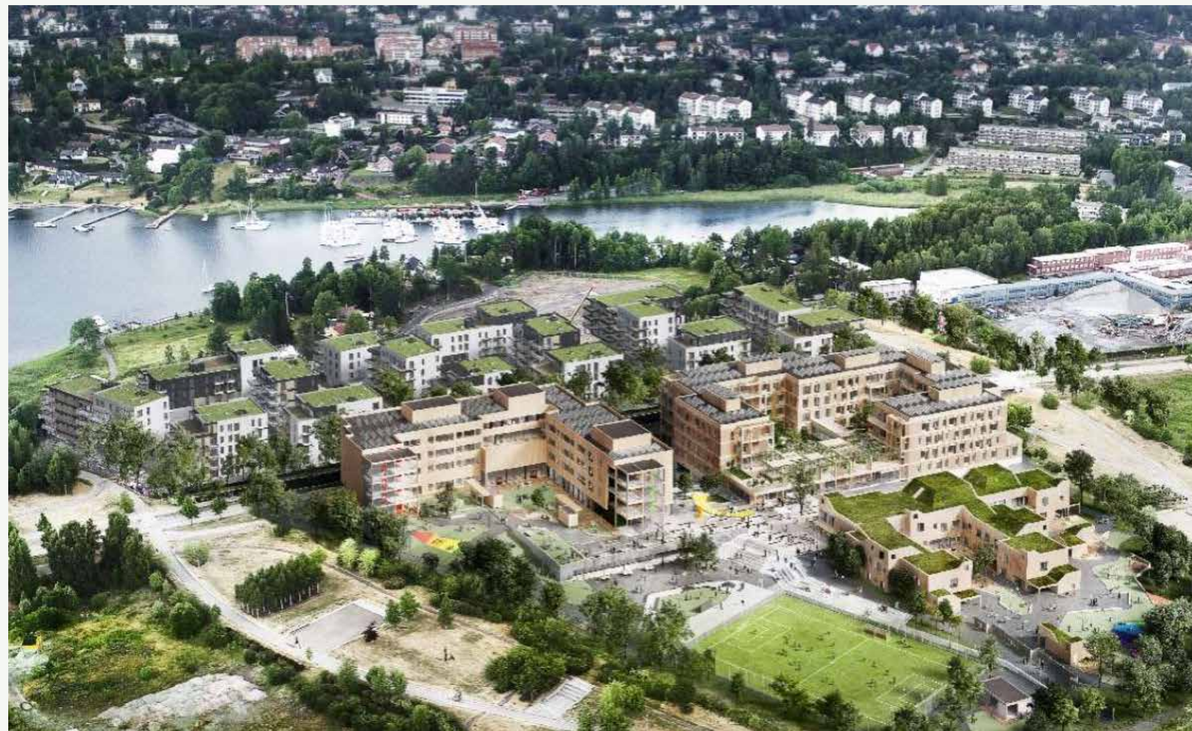
Prosjektet Treklang på Fornebu. Barnehage, barneskole og sykehjem på samme område. Første trinn ferdig 2022.
