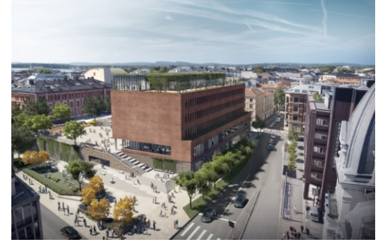
Ruseløkka skole – 930 m 2 solceller i fasaden og tak
