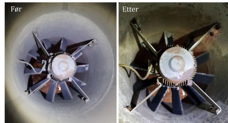
Figur 18 Effekten av tørris på vifte
