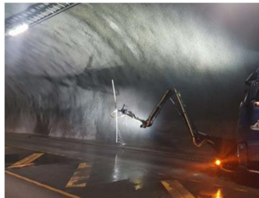
Figur 27 Sprøytebetong i Valderøystunnelen.
