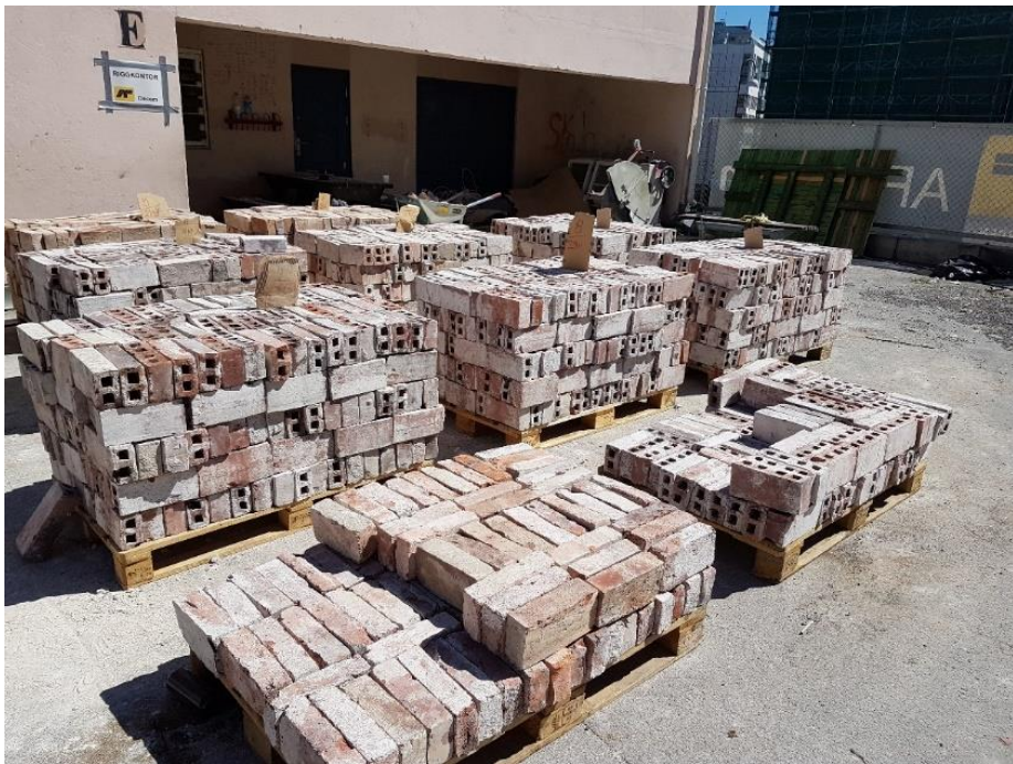
4500 teglstein er lagret på Sogn vgs
