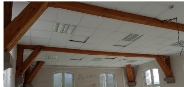
En av tredragerene er tatt ned til ombruk
