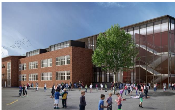
Slemdal skole, solceller på tak
