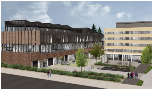
Etterstad vgs, solceller på tak
