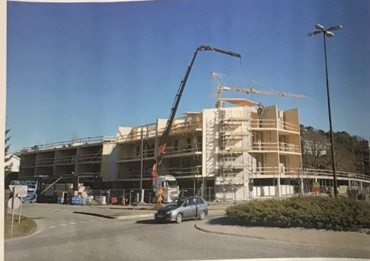
BYGGING. Montering av massivtrelementer for Skonnertveien Hageby startet i mars, og i desember skal første byggetrinn være klart til innflytting. Foto: Massivtre
