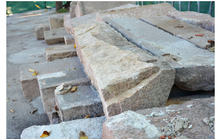
Trappetrinn i granitt er lagret for ombruk
