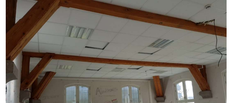
En av tredragerene er tatt ned til ombruk
