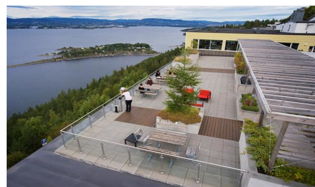
Sunnaas sykehus HF 3. byggetrinn
