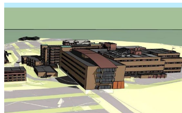
Sykehuset Telemark HF Utbygging somatikk Skien
