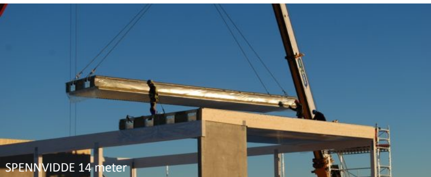
ELEMENTTYKKELSE 610 mm , U-verdi 0,09 W/m 2 K, BRANNKRAV REI60
