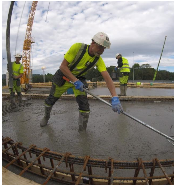
Sement og betong
